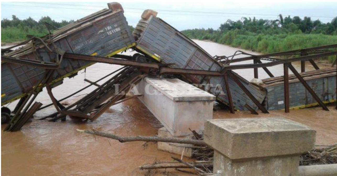
El viernes 7 de diciembre del 2014, a las 10:50 horas, colapsó la estructura metálica en dos de los tramos del puente ferroviario de 300 metros que la Línea Belgrano atraviesa sobre el río Colorado, Salta. La falta de mantenimiento en la estructura del puente y sus bases son notables. Siempre, en todos los puentes del ferrocarril se realizaba un mantenimiento preventivo, en verano por contracción del material en invierno o dilatación verano.
